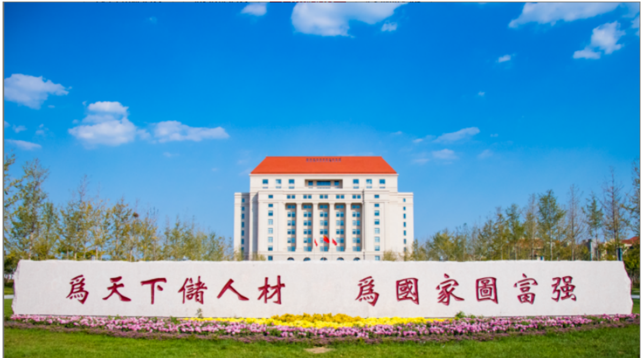
Main gate 大门
